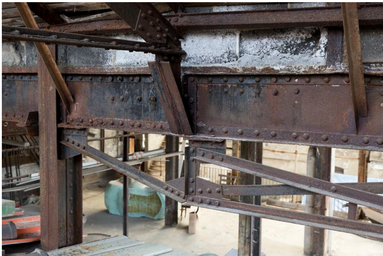
B : détail de charpente entre les bâtiments B et E.
