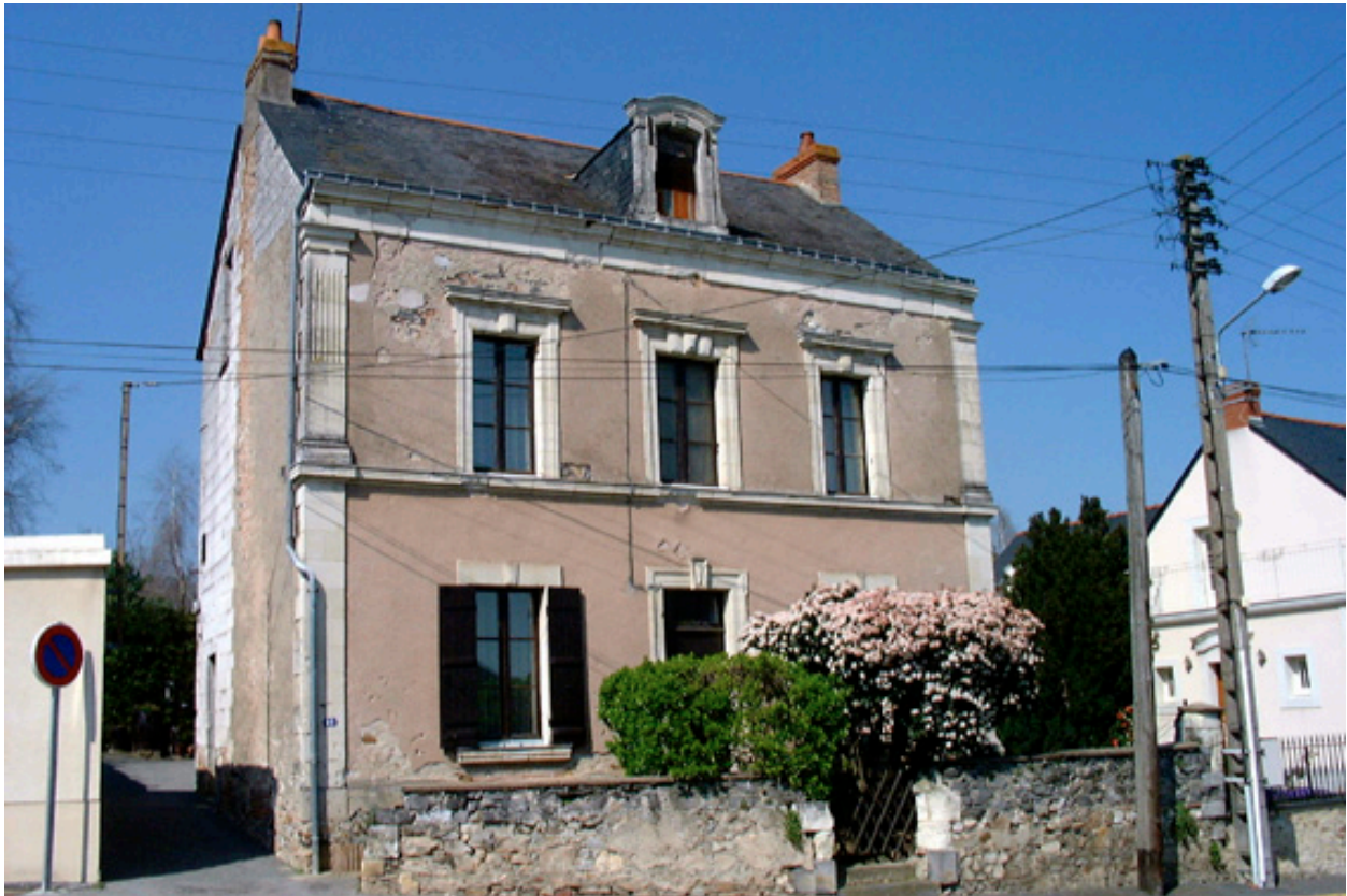
Maison à étage carré et façade ordonnancée.
