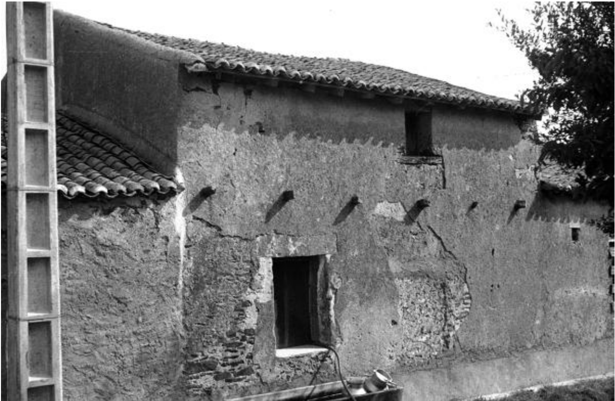
La Commazière. Vue de la façade sur rue prise lors du pré-inventaire en 1972.
