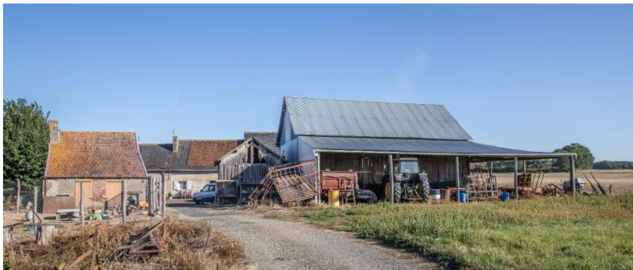
Ferme 2, vue d'ensemble depuis le chemin.
