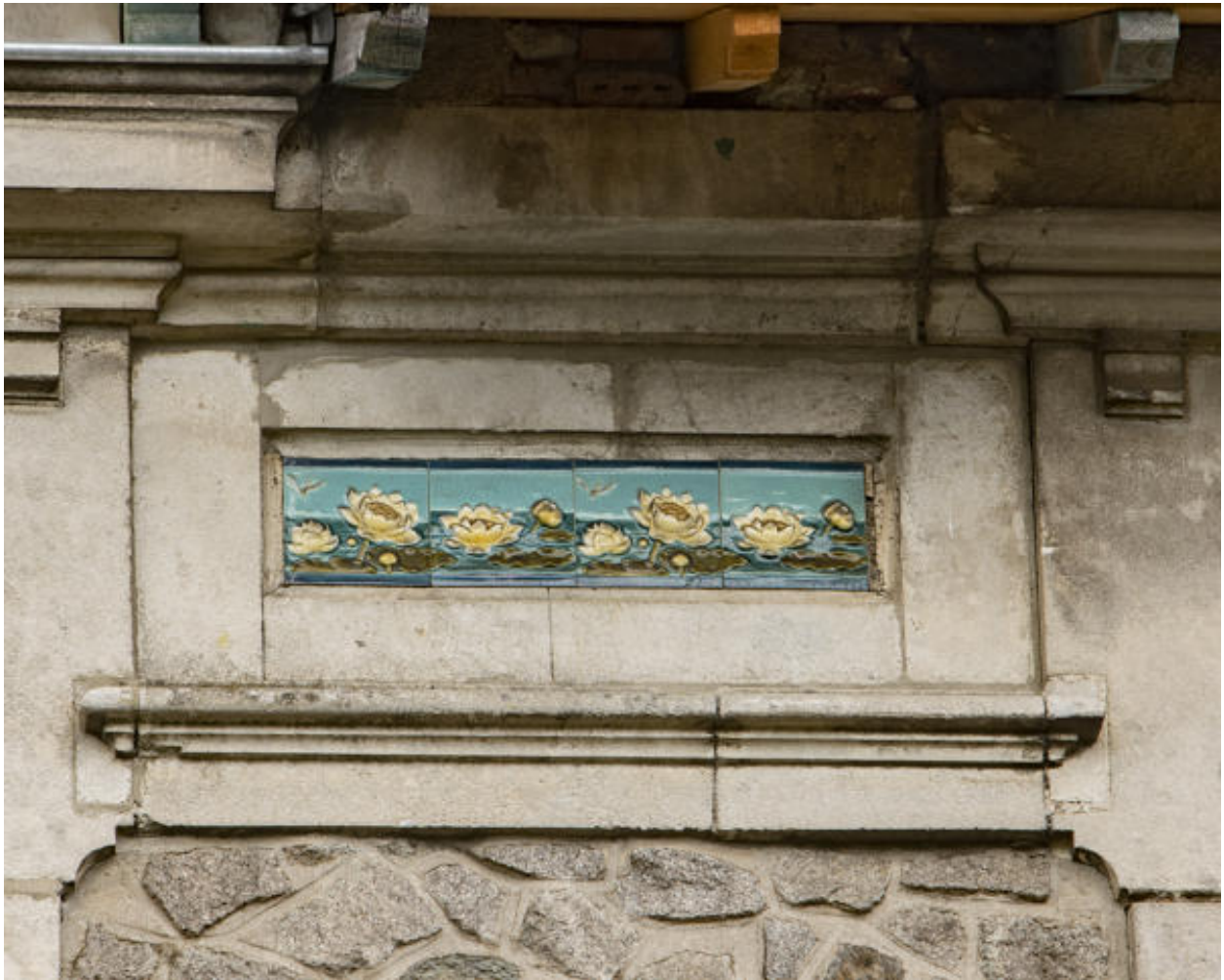
Maison "Ker Marie", 7 rue du Port. Détail de la frise en carreaux de céramique.
