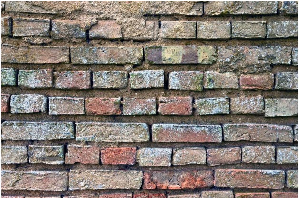
Détail de la maçonnerie de briques enduites.
