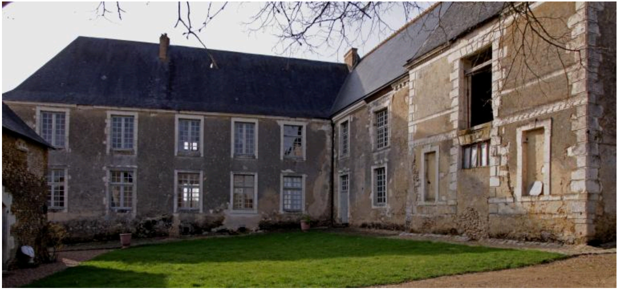
Façades sur cour.
