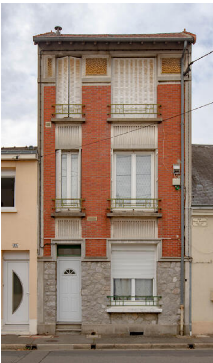
Vue d'un immeuble collectif avec parement brique rue Henri-Barbin.
