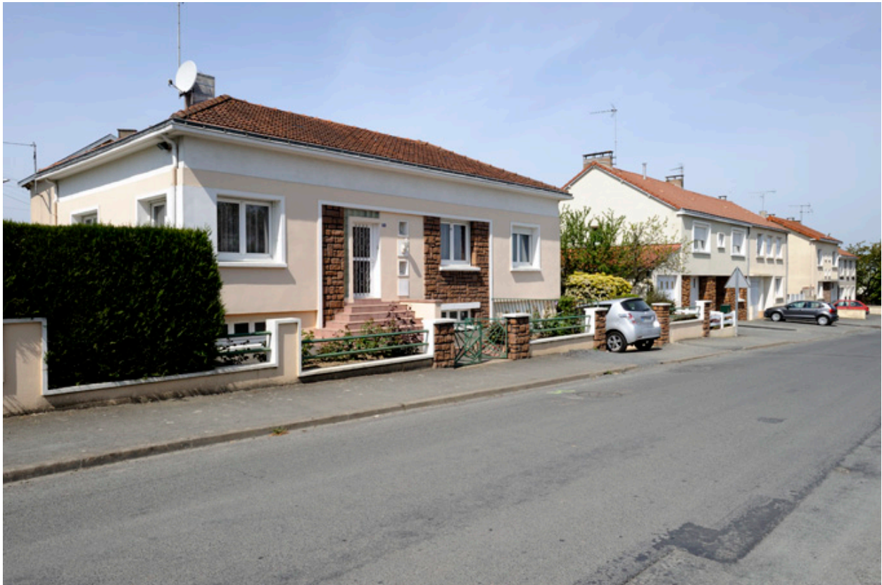
Lotissement Le champs du bois vert, rue d'Anjou, construit entre 1958-1959.
