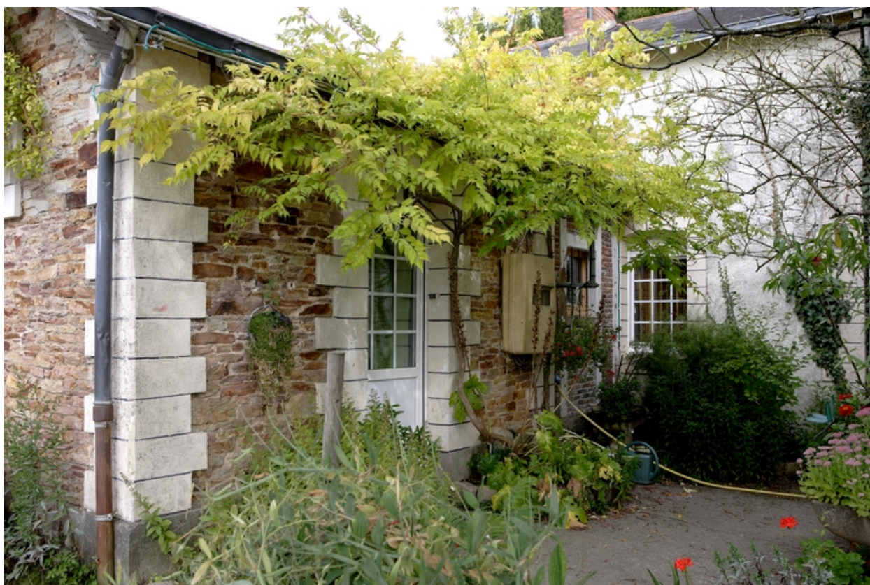
Entrée de l'annexe destinée aux voyageurs.
