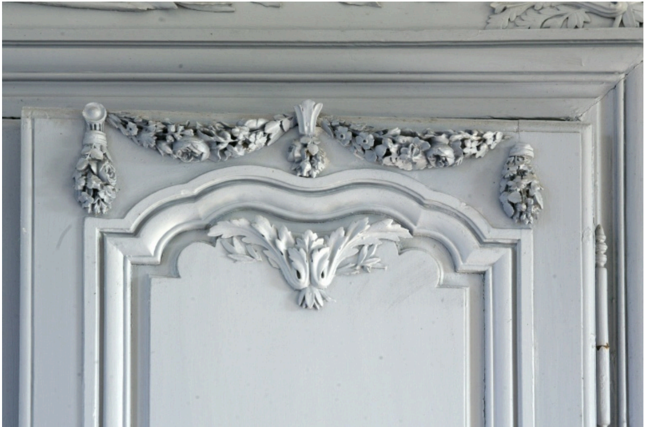
Hôtel Saint Clair, grand salon au rez-de-chaussée, détail de sculpture de la porte communiquant avec la bibliothèque.
