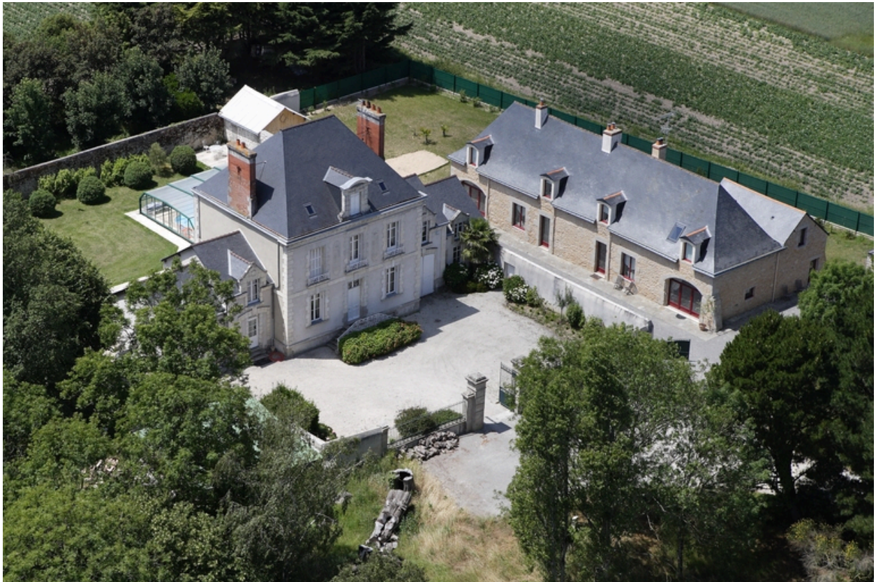
Vue aérienne depuis l'est.
