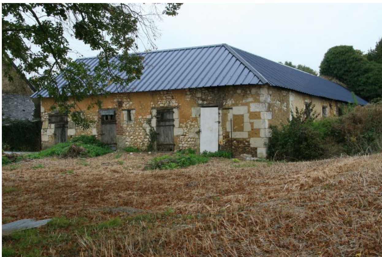
Les étables, aile en retour d'équerre vers la maison : façade postérieure.
