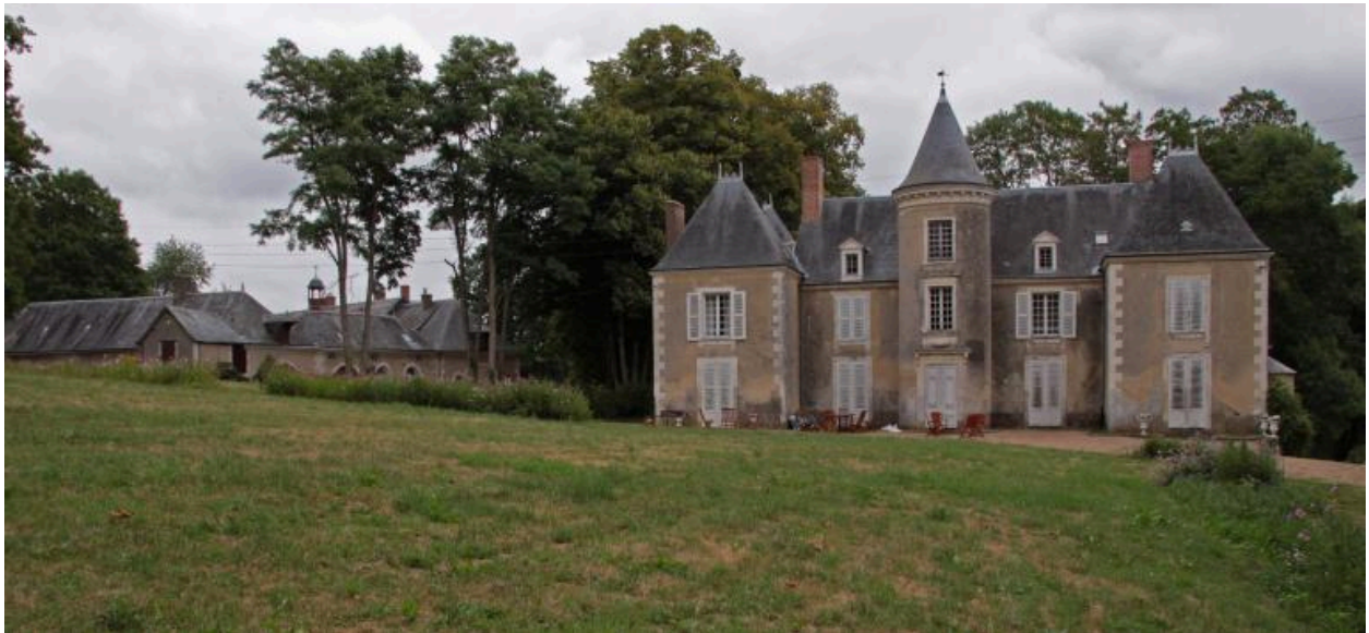
Vue générale du château, côté jardin, avec écuries et dépendances en arrière-plan.
