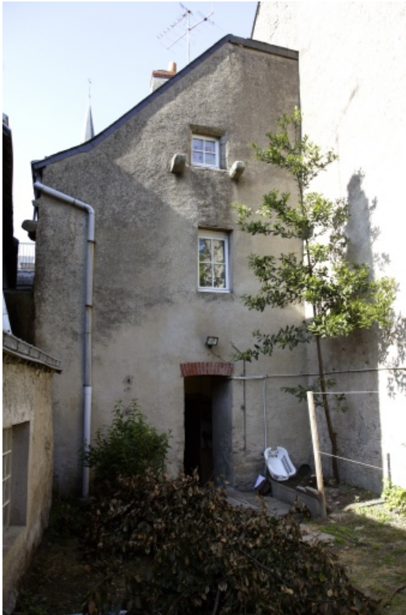
Pignon sud de la partie arrière.
