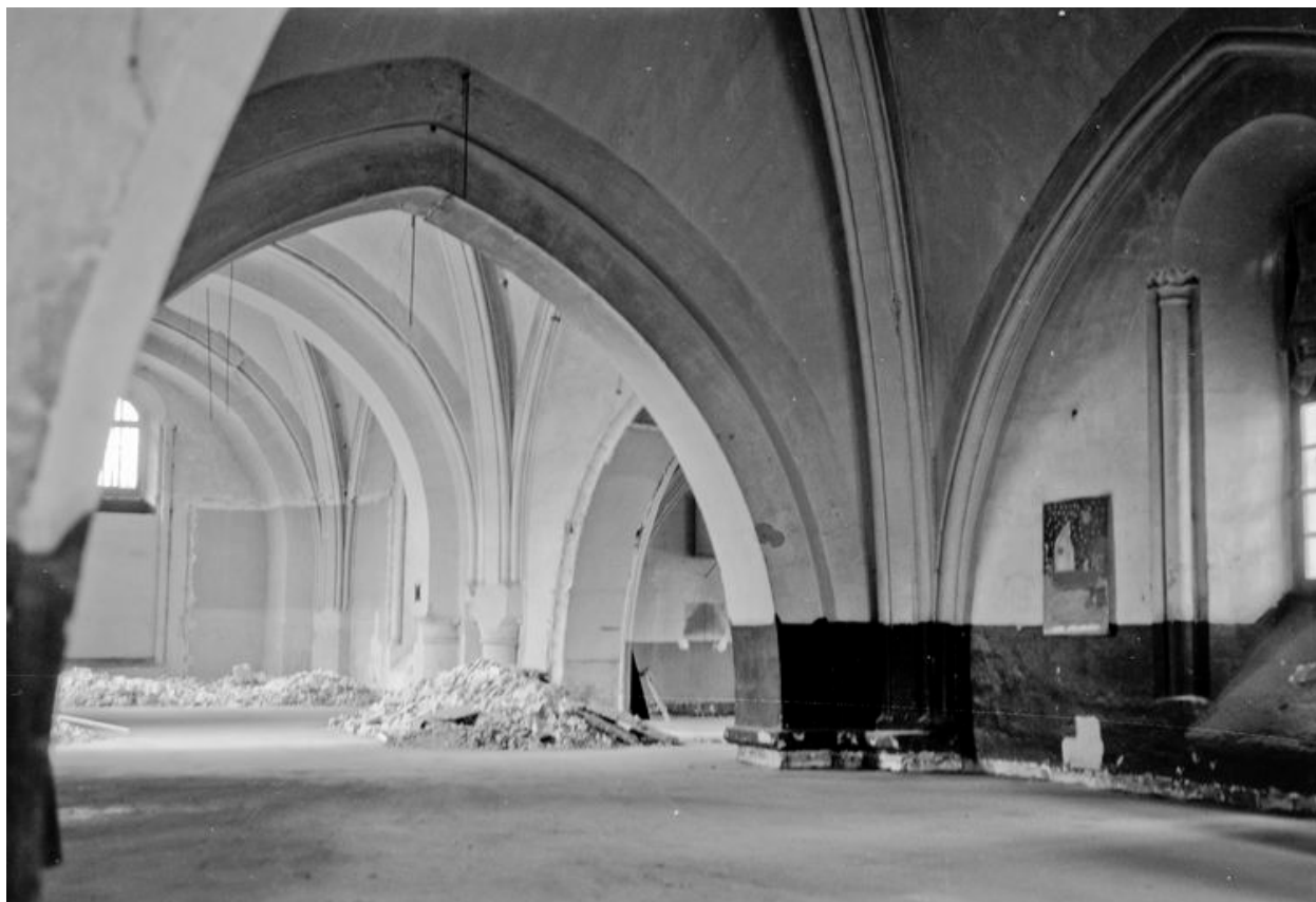
Prieuré Saint-Lazare, nef divisée par un plancher (vers 1958-1960, début des restaurations) : étage.
