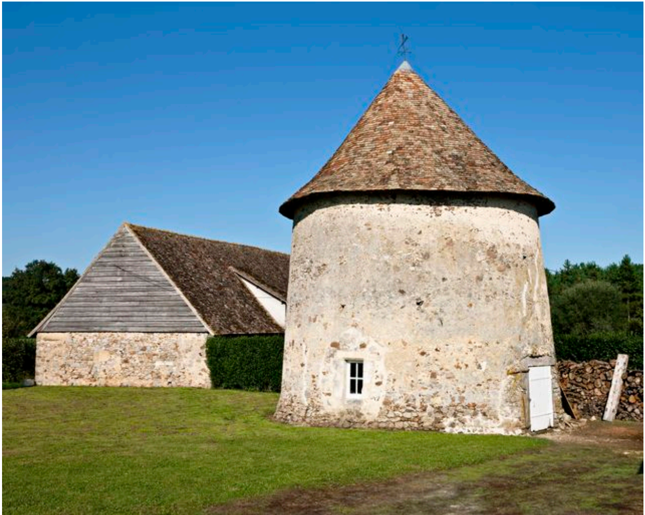
Le colombier et le mur-pignon gauche de la grange-étable.
