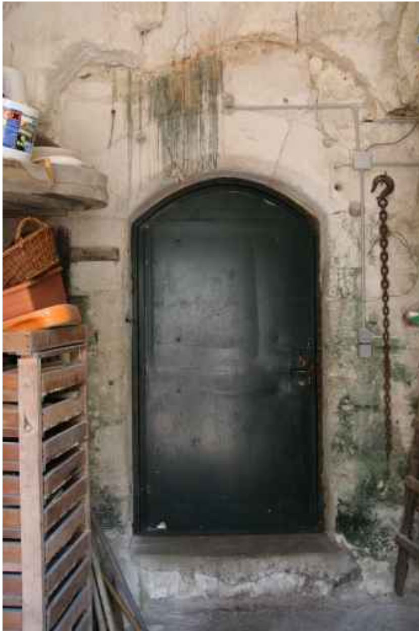
Rez-de-chaussée de la tour : porte de la cave.
