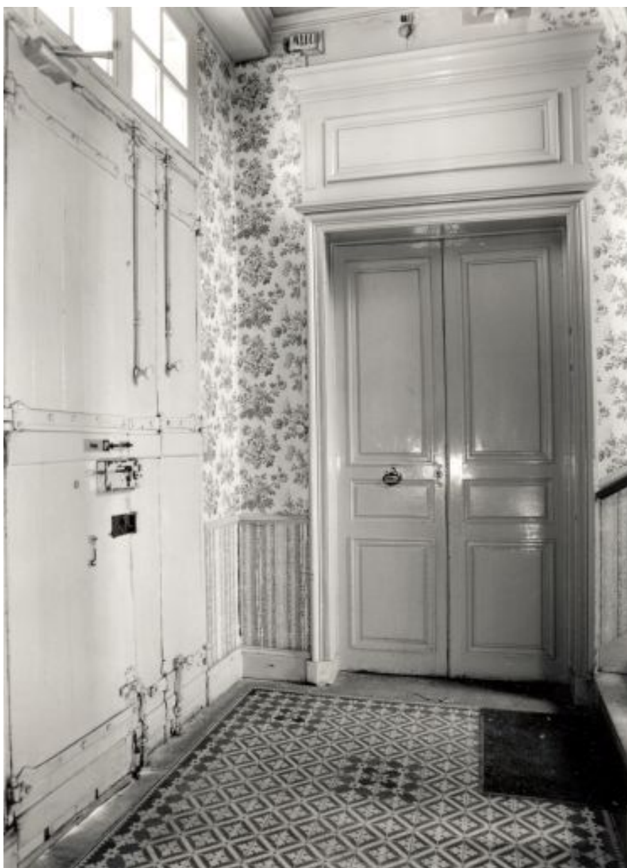
Vestibule : porte gauche, vers le salon.
