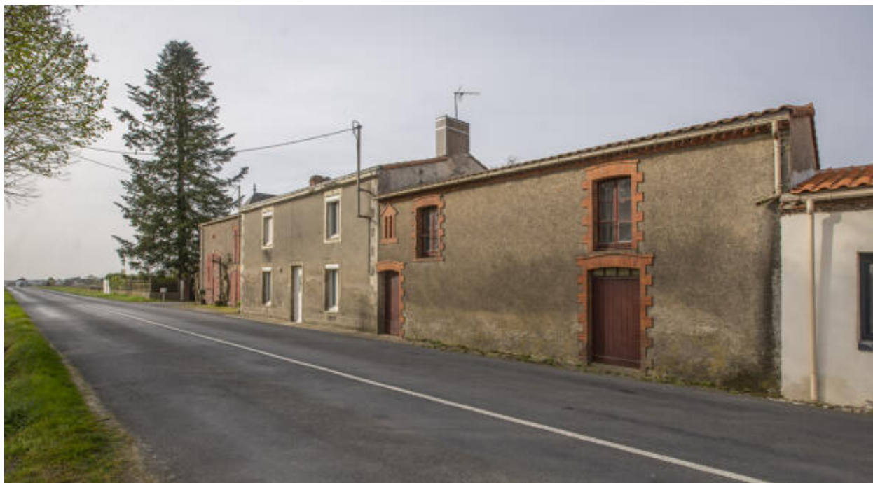
Bâtiments des négoces Chéneau à la Chevalerie, Vallet.
