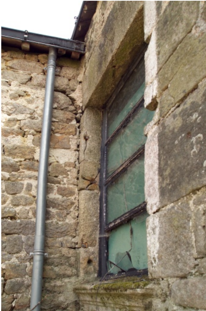
Bâtiment sud, détail fenêtre.
