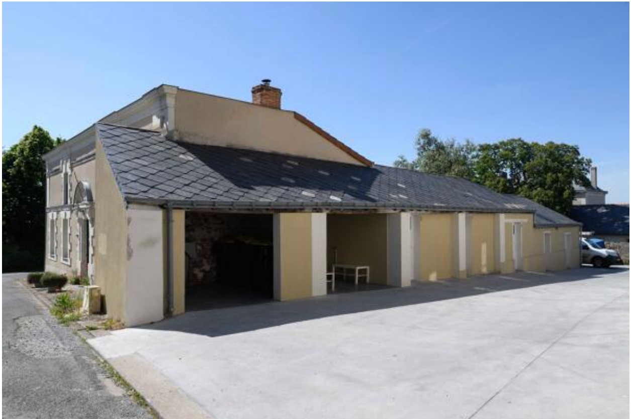
Vue du préau depuis le sud-est.
