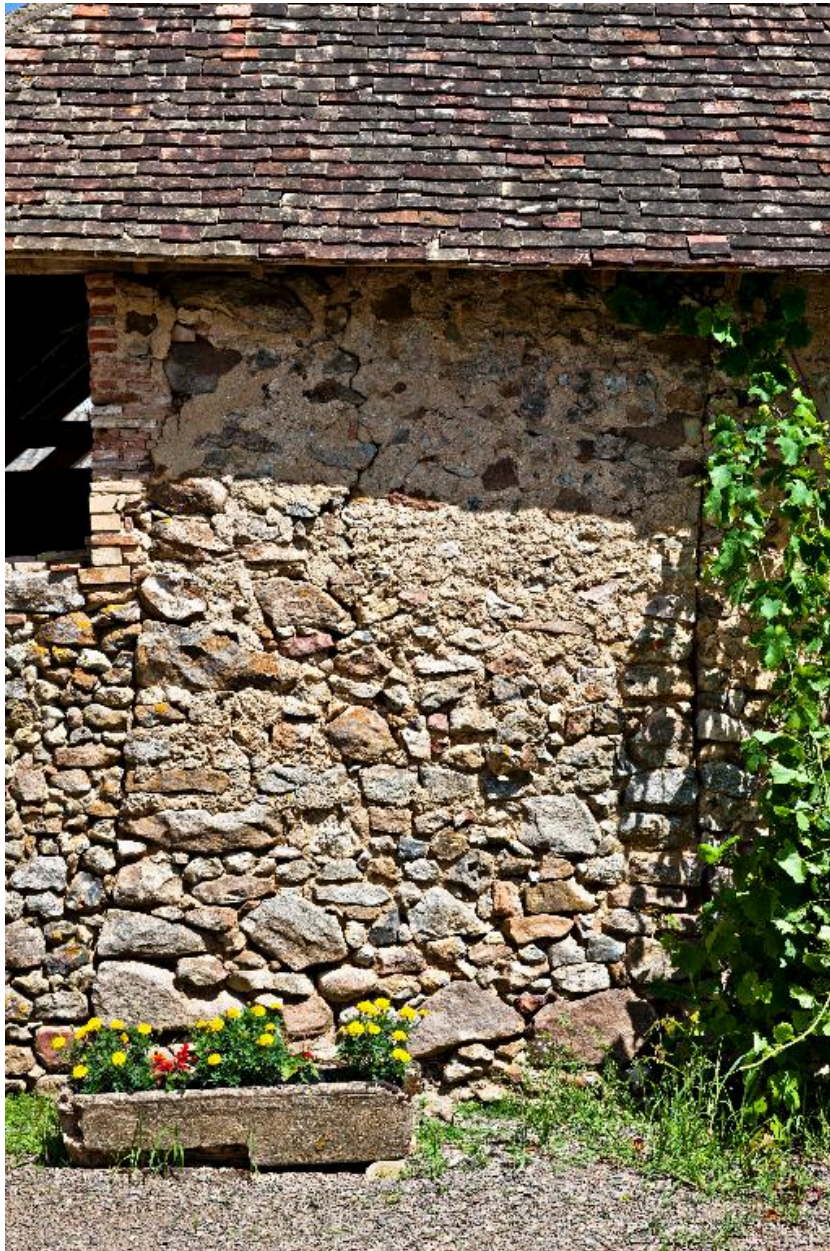
Détail de l'élévation antérieure du logement et du fruit du mur-pignon portant la cheminée.
