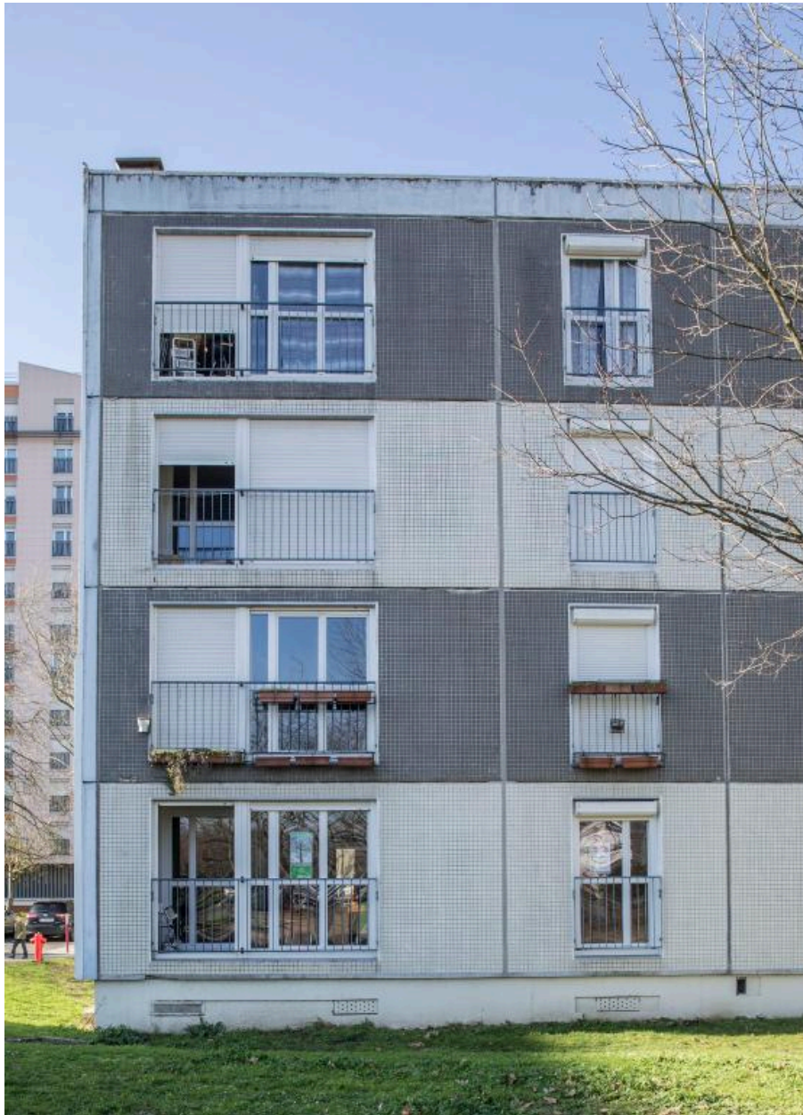
Vue des deux travées sud de la barre à logements.
