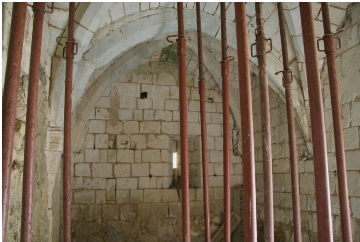
Ancien château, 2e salle voûtée : 2e travée.
