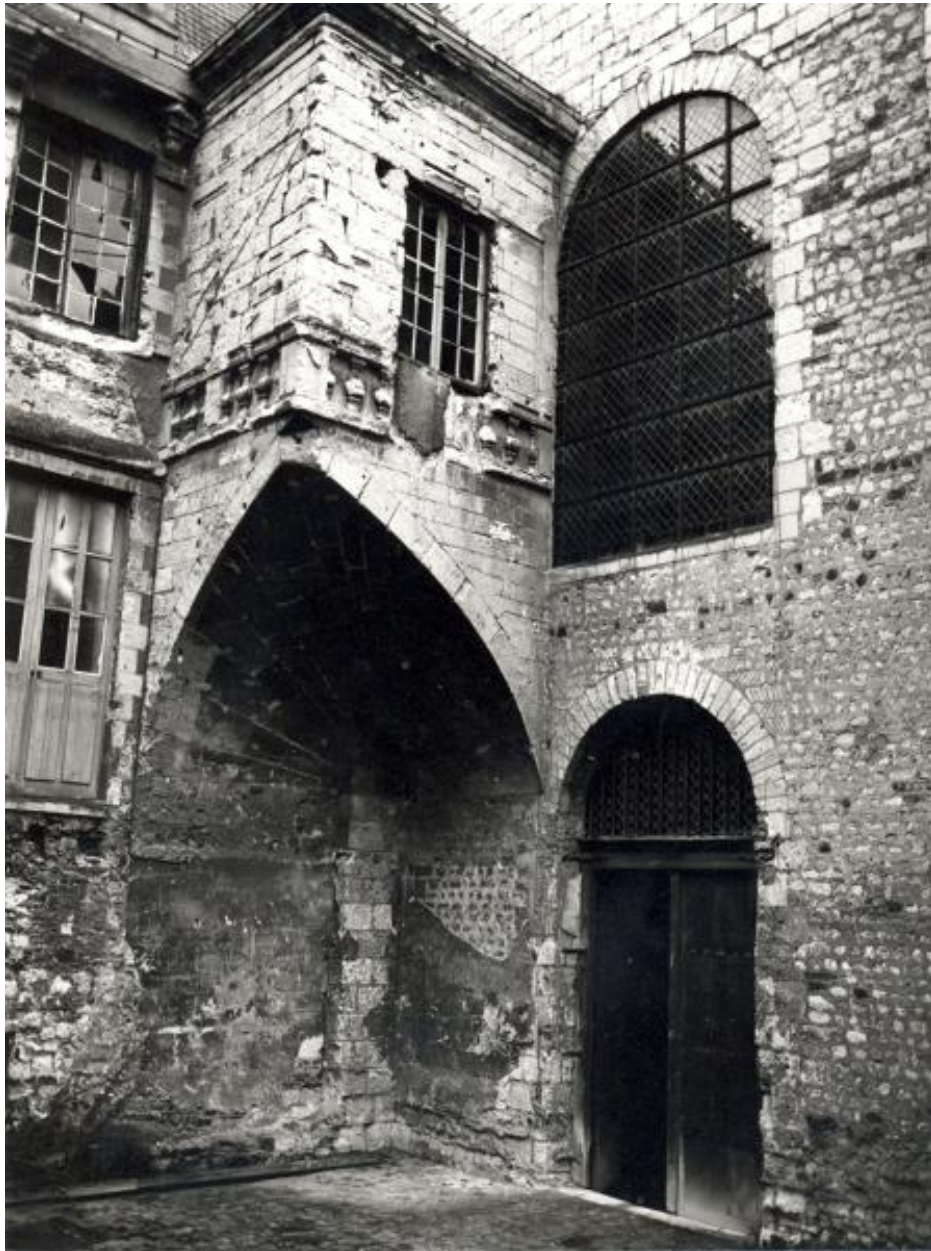
Eglise, pignon occidental, angle nord.
