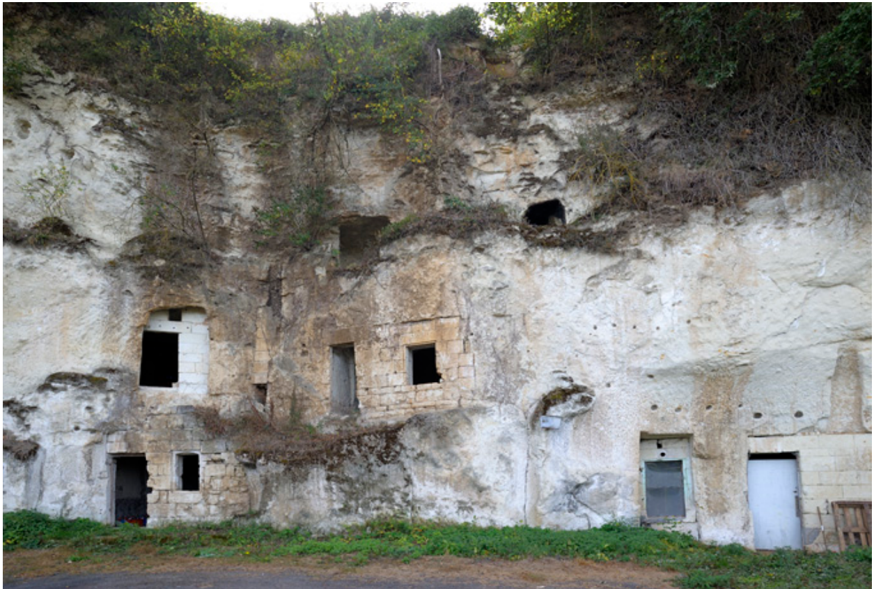
Chemin dit des Caves (parcelles 2011 B 221, 223 et 224). Habitations et communs troglodytique (XVIIIe siècle ?).
