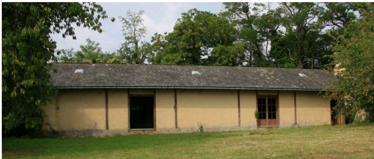
Bâtiment du jeu de boule de fort.
