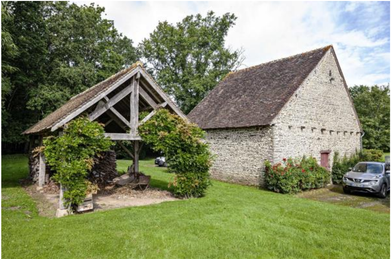
Loge à pressoir et grange.
