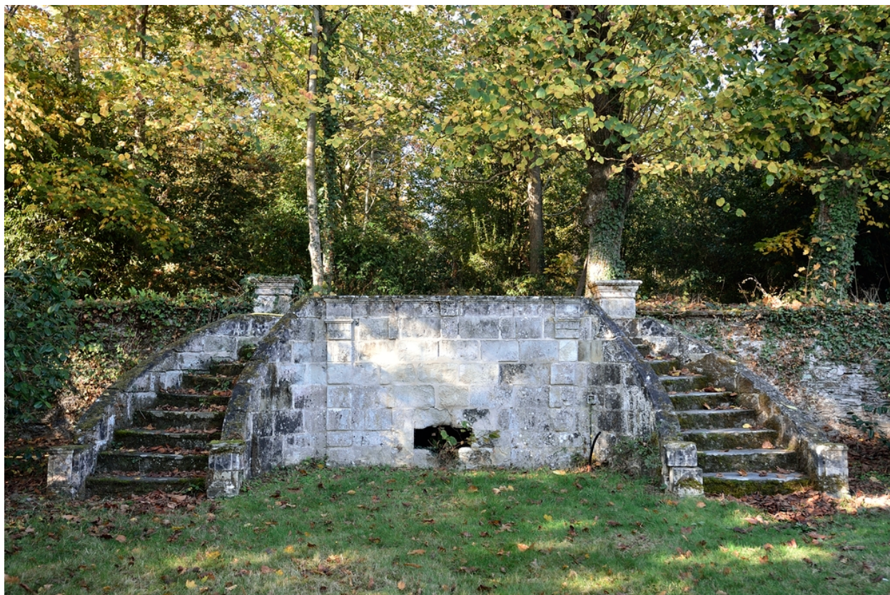
Vue de l'escalier en U permettant d'accéder à la deuxième terrasse.
