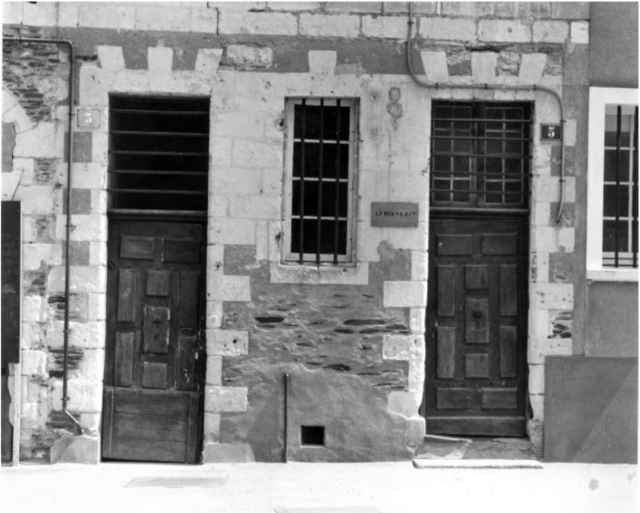
Elévation antérieure : portes d'accès à la cour et à l'escalier.
