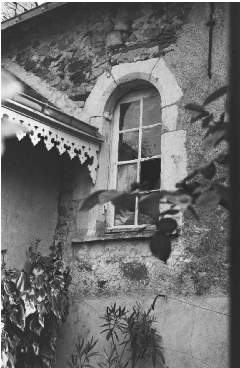
Façade ouest : détail d'une baie cintrée et chanfreinée en tuffeau.
