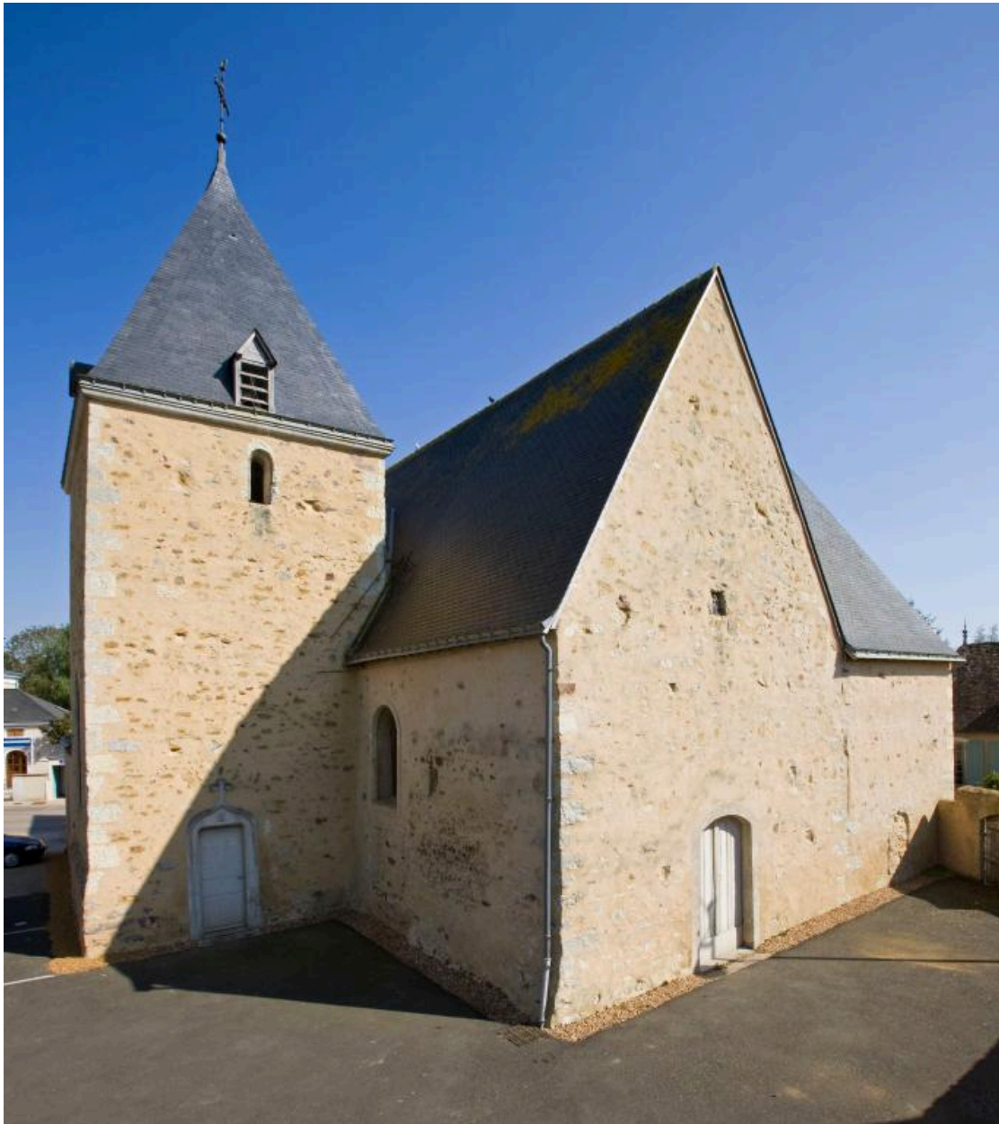
L'église vue du nord-ouest
