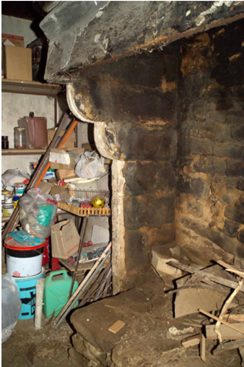
Corps principal, rez-de-chaussée, pièce orientale, cheminée, détail du montant gauche.
