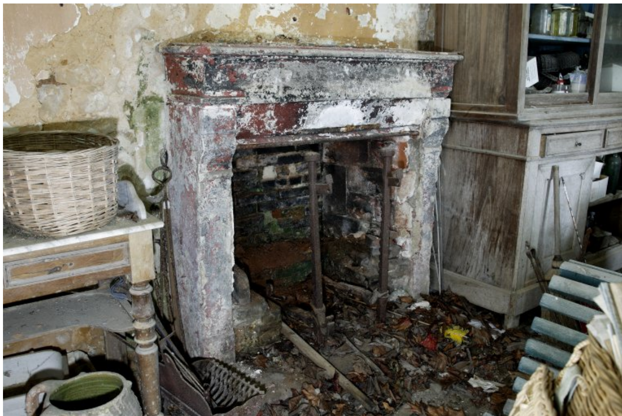
Cheminée du bâtiment de commun.
