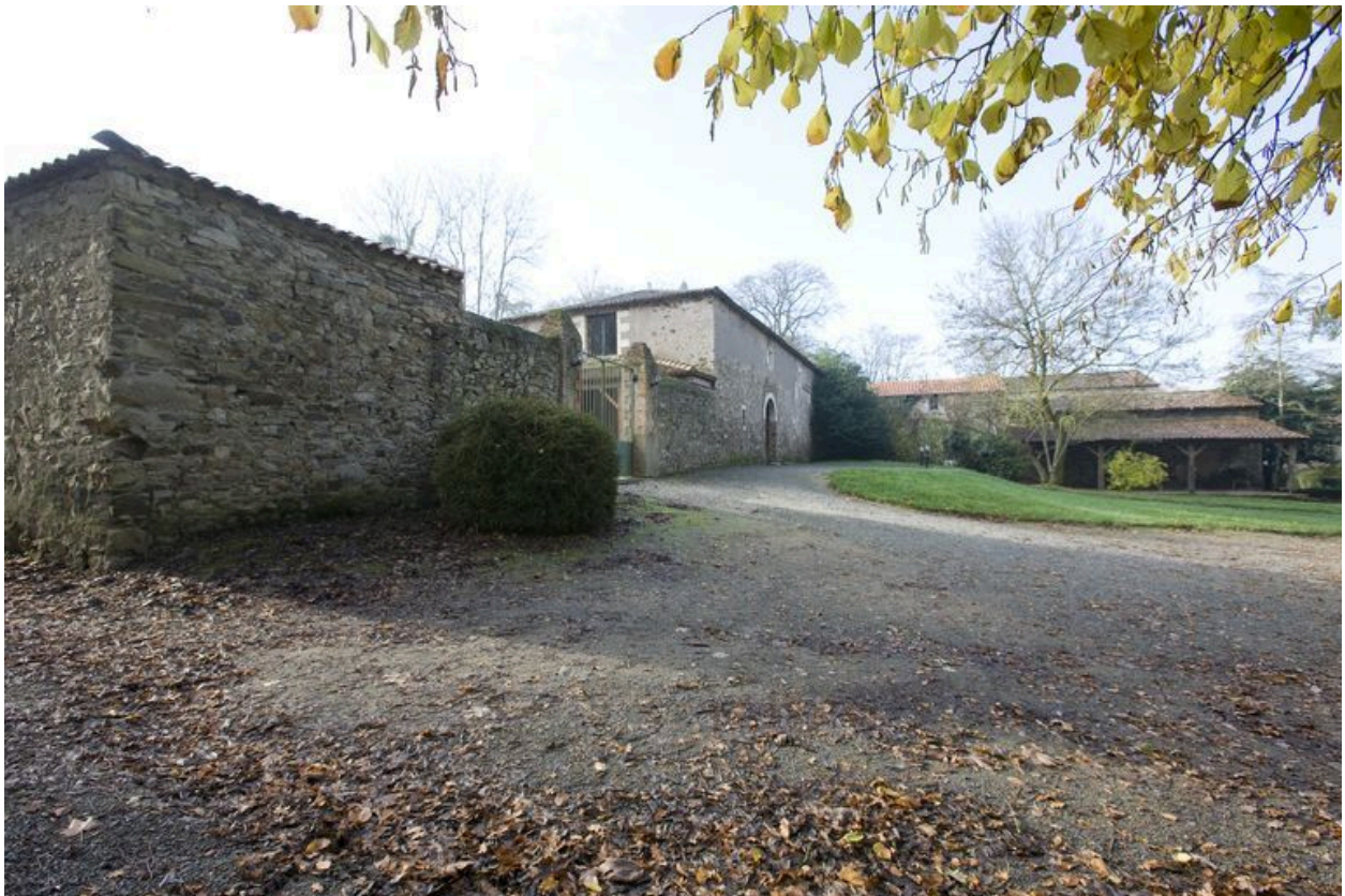
L'ancienne écurie et le portail de la petite cour fermée : façade nord.
