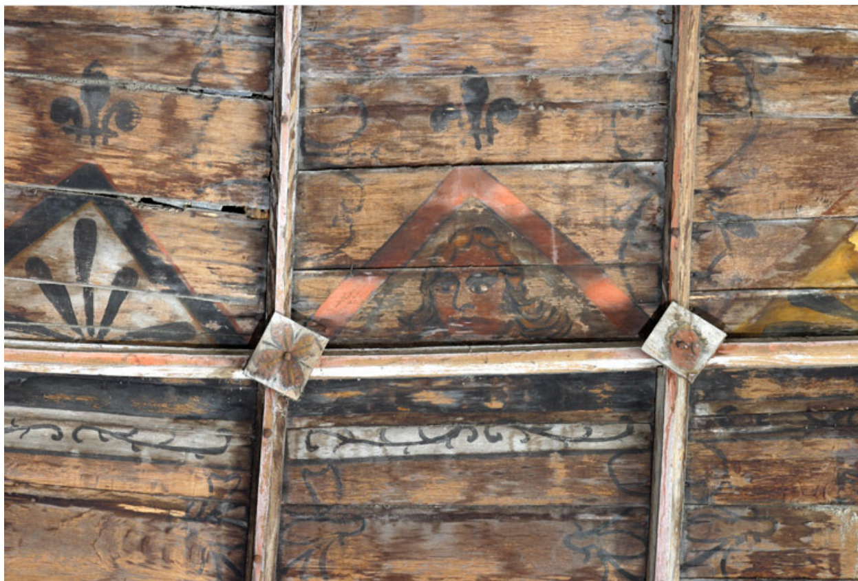
Nef, voûte, côté sud, deuxième travée, registre médian : tête d'homme.
