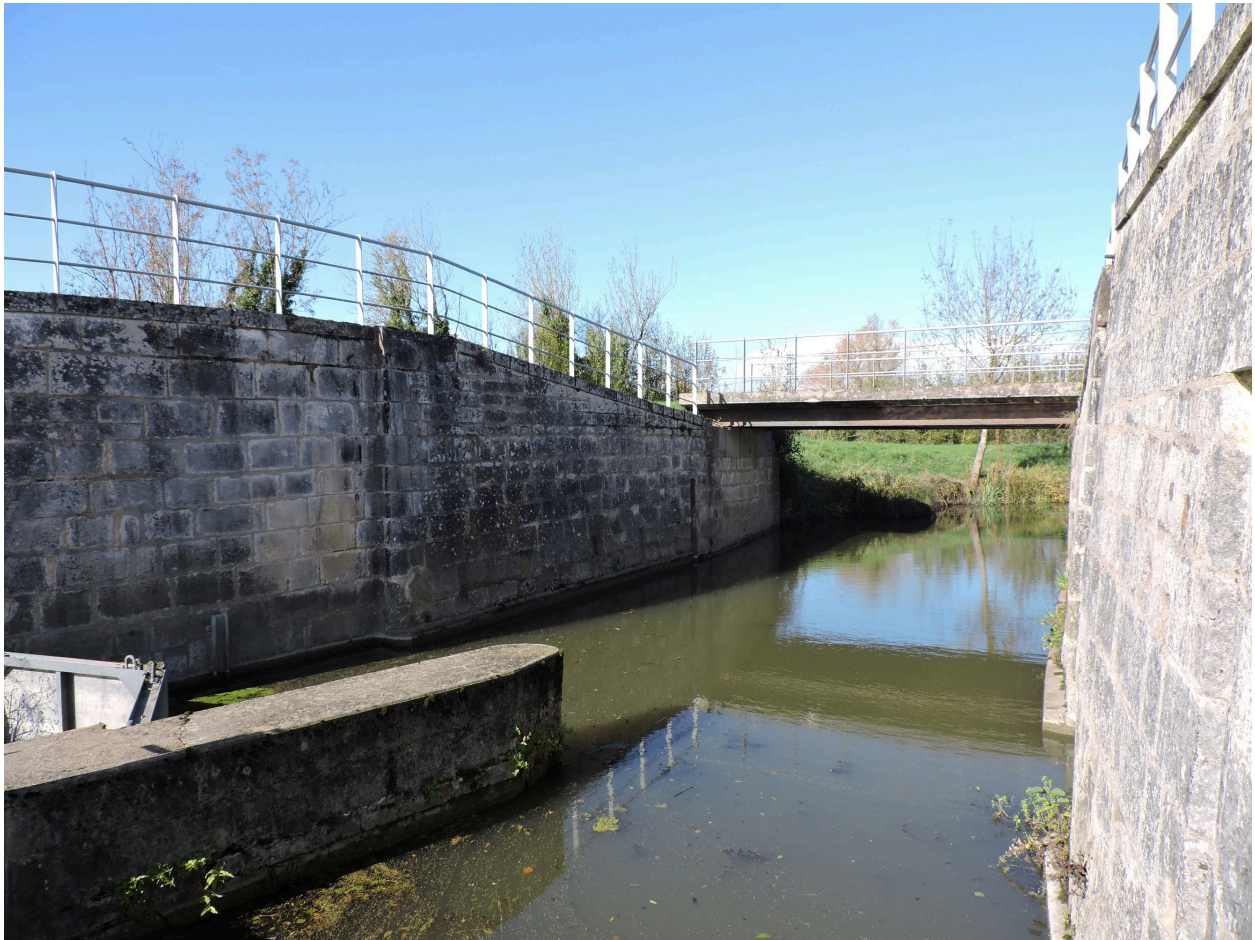
Le passage de la Jeune Autise sur l'ancien aqueduc, vu depuis l'amont.
