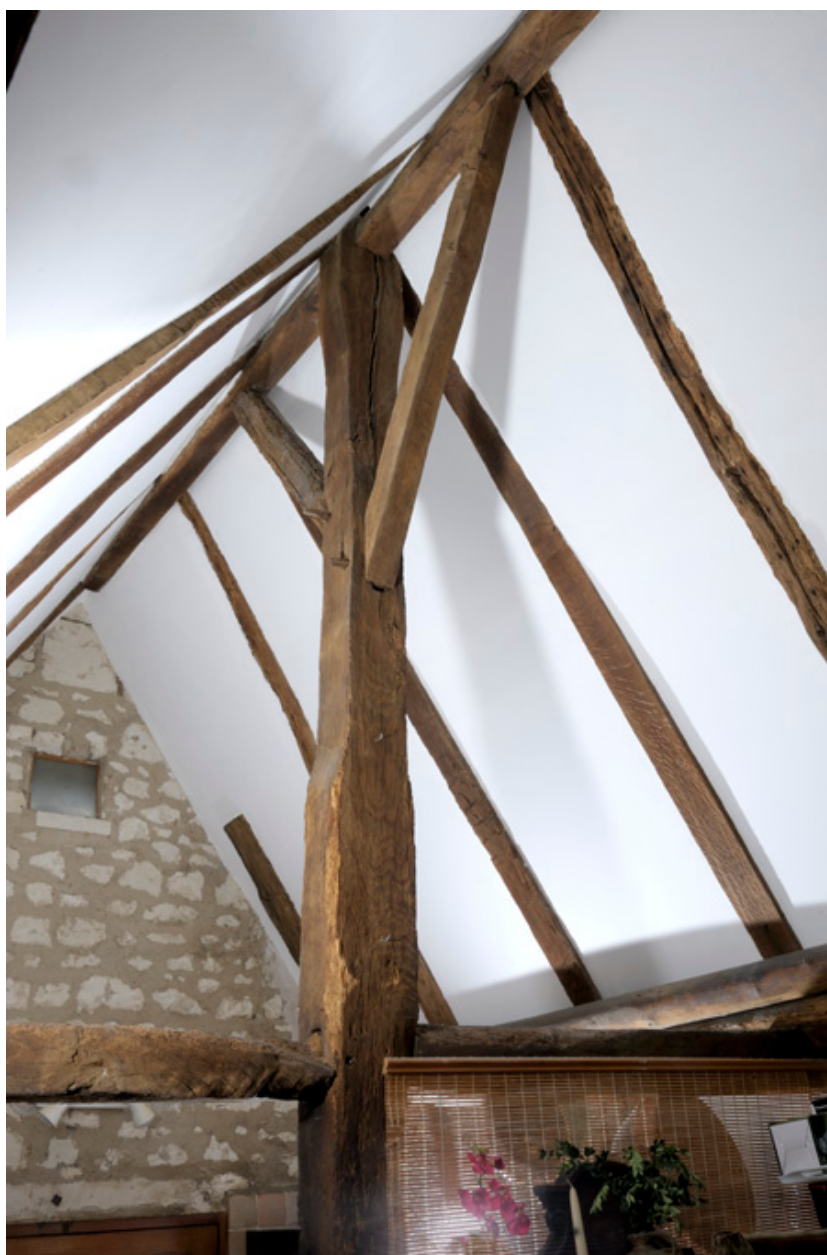
Comble : vue de la charpente, détail du poinçon sud et du contreventement.
