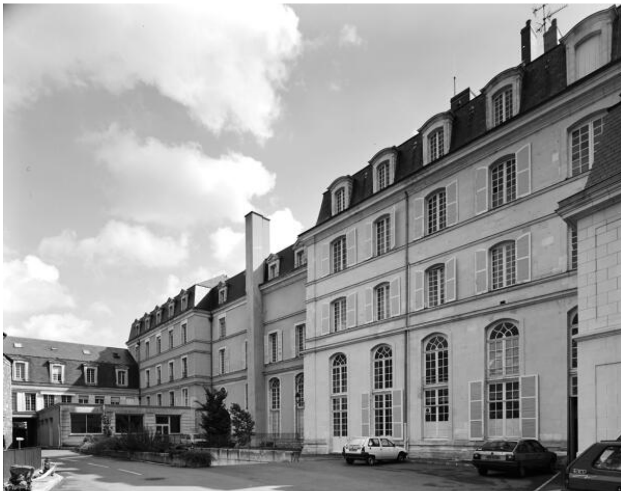
Abbaye, élévation ouest sur la cour de service. Avec élévation postérieure (sud) du bâtiment d'entrée de la préfecture.
