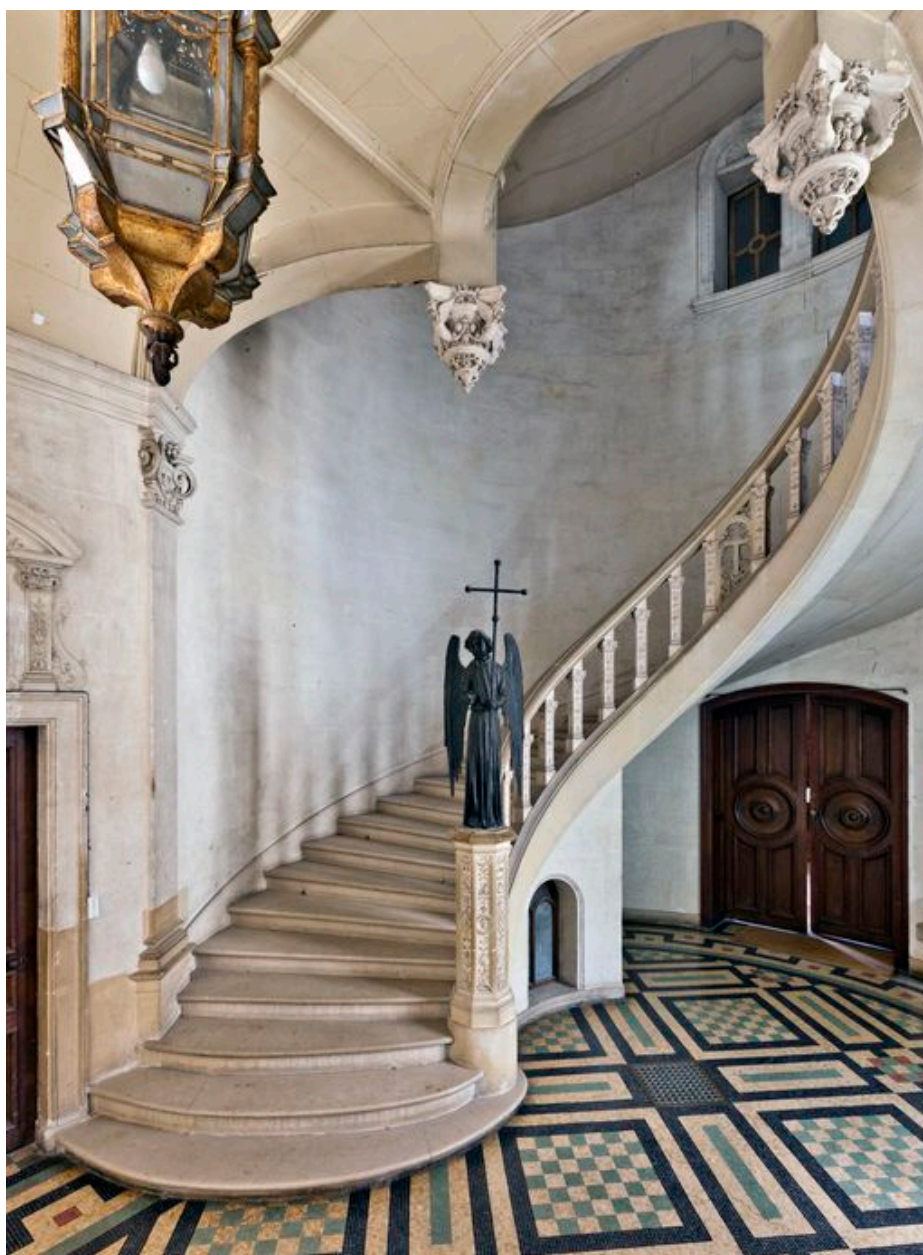
Tour nord-ouest : escalier en vis suspendu.
