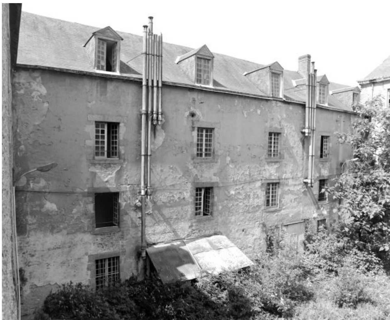
Couvent, élévation sud-ouest sur cour : vue d'ensemble.
