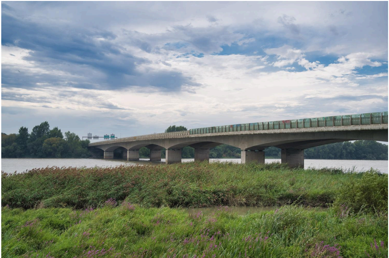
Vue générale du pont de Bellevue et de la Loire.
