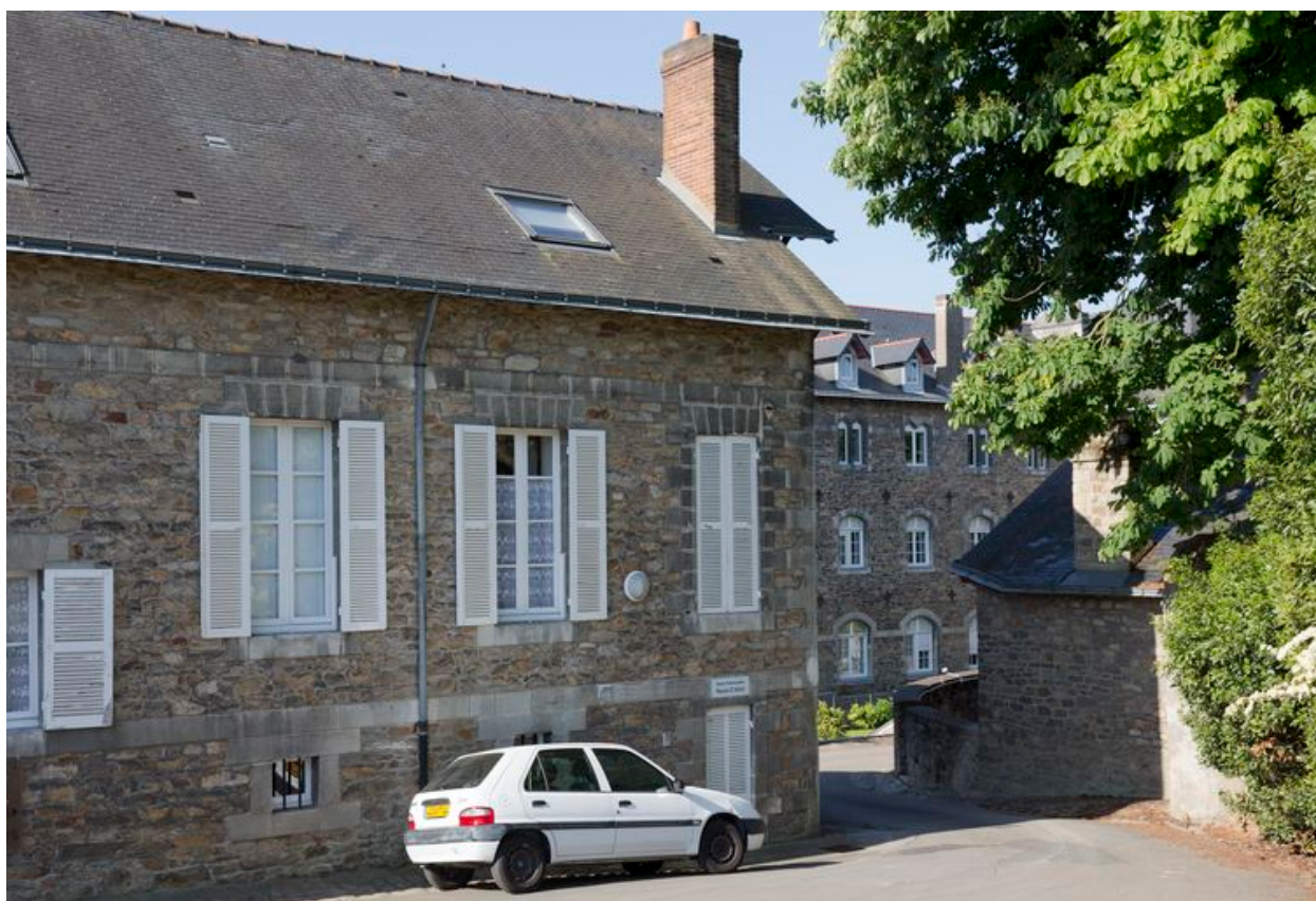
2 : infirmerie, façade nord et passage vers le bâtiment de la communauté.
