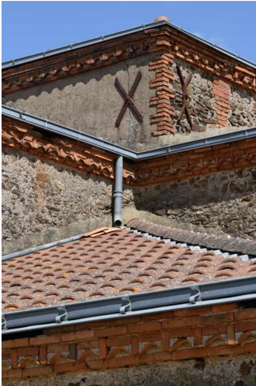
Détail des jeux de toitures de l'angle sud-ouest.
