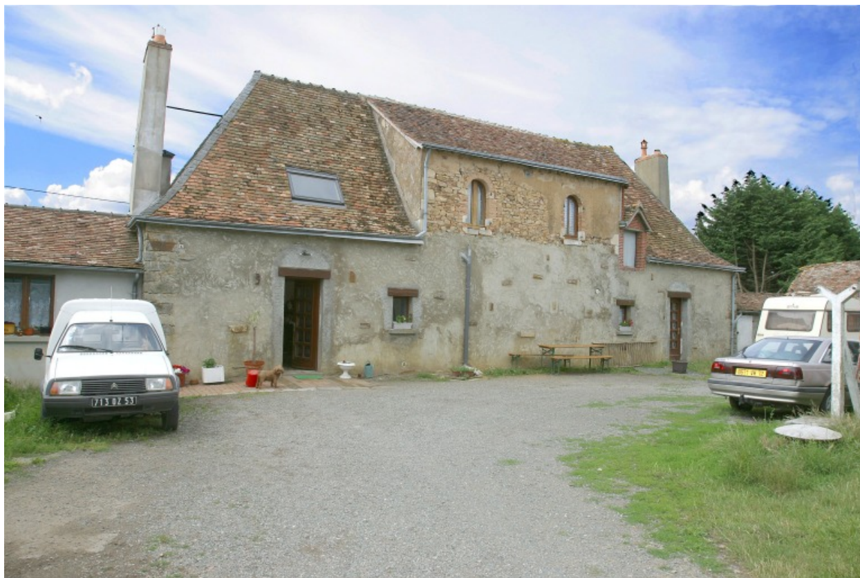
L'élévation postérieure du logis, au nord.
