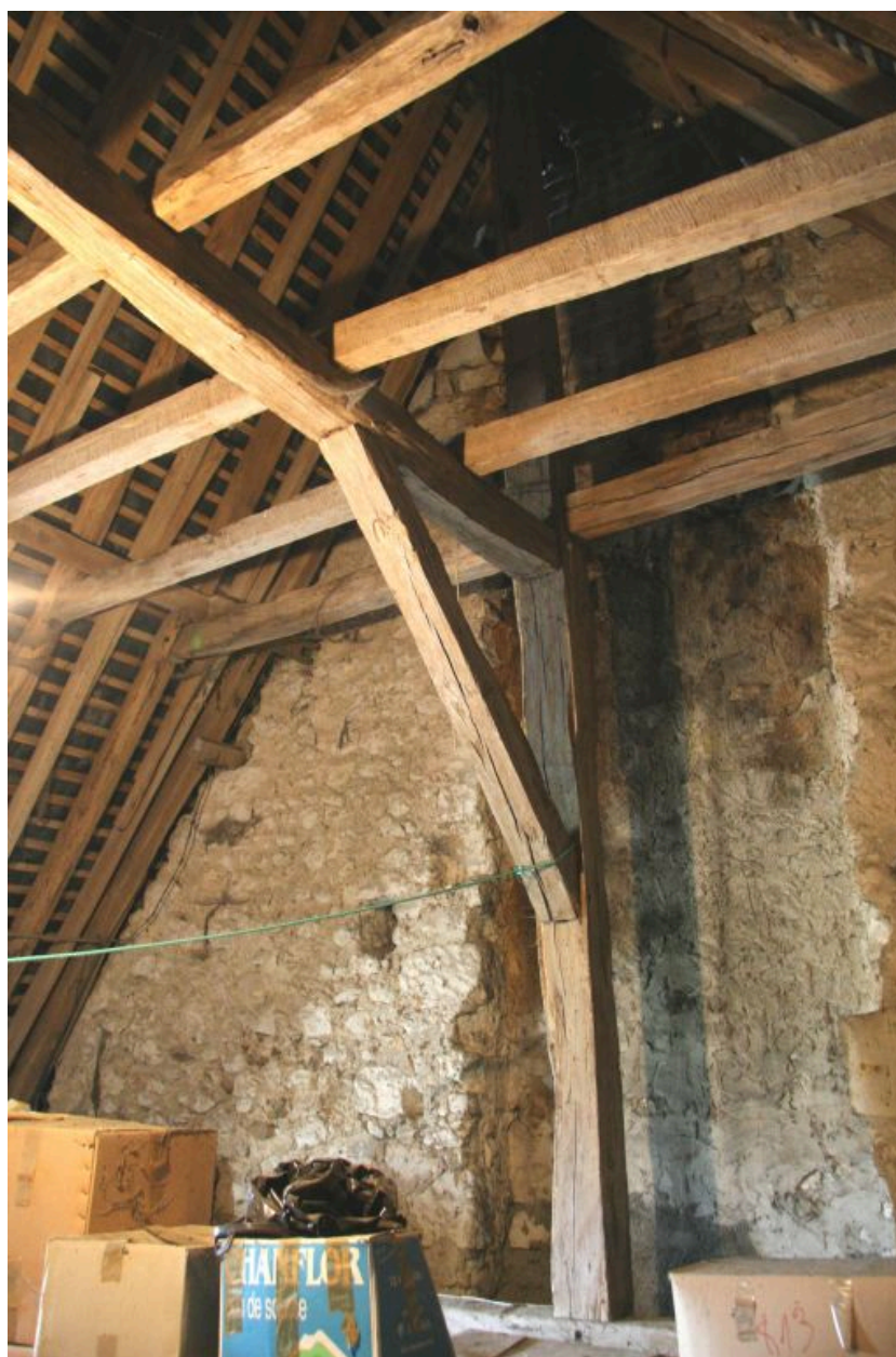
Charpente de la maison : poinçon.
