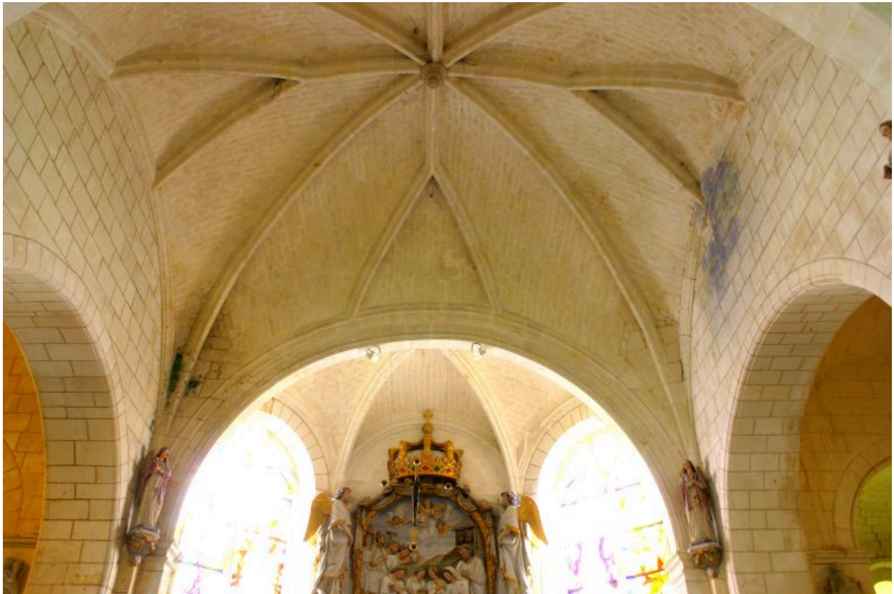
Voûte du chœur.
