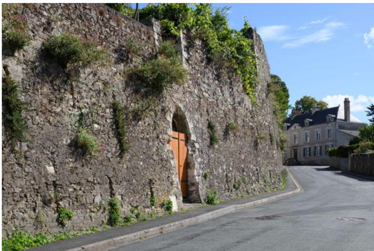
Vue d'ensemble de la partie ouest de l'enceinte urbaine.
