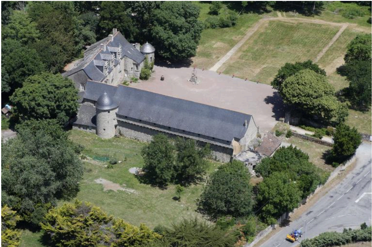
Vue aérienne du château de Careil depuis le sud-ouest.
